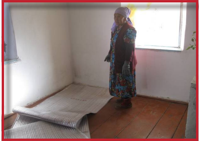
Laying folgoizol on timber floor
